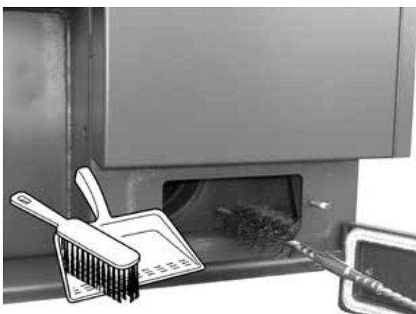
Muster – die Reinigung des Rauchkanals – unterer Deckel
